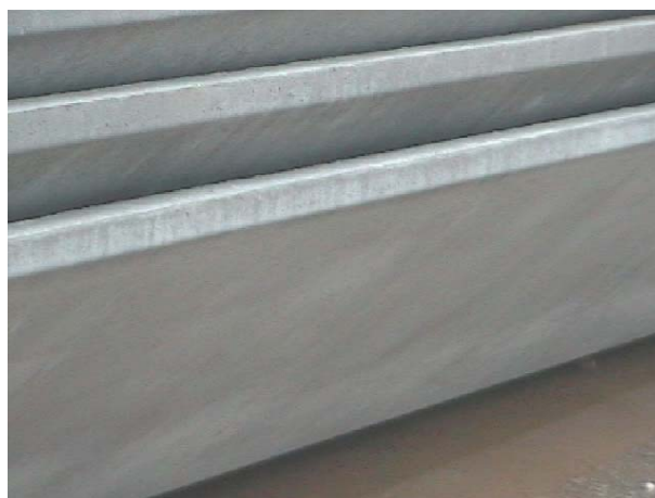
Figura 13. Vista della superficie inferiore dell'ala.
