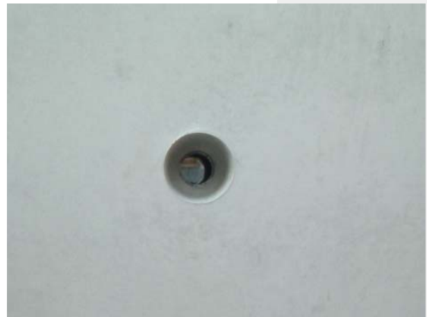
Fig. 8 - Dettaglio del faccia a vista
