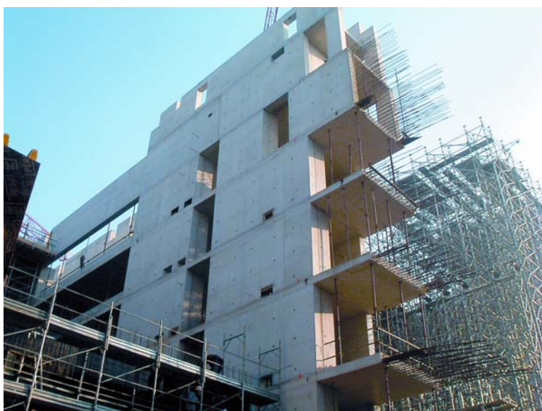
Fig. 1 - Panoramica del cantiere in via Bligny.
