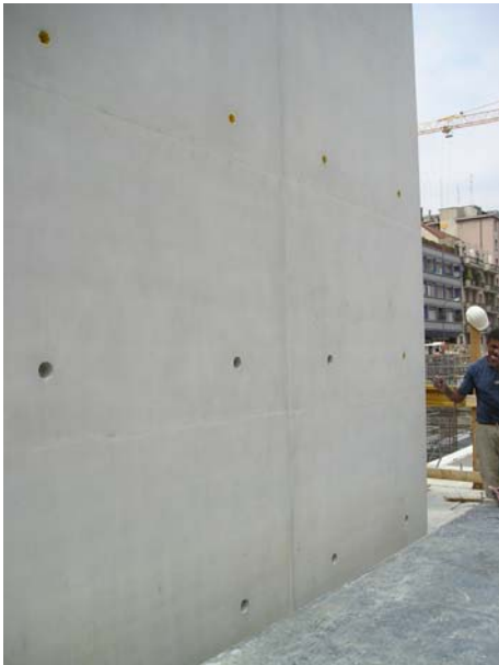
Fig. 7 - Dettaglio del pilastro.
