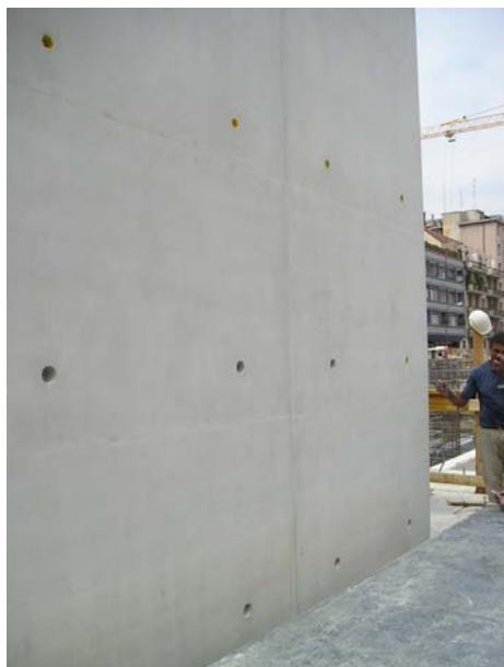
Fig. 7 - Dettaglio del pilastro.
