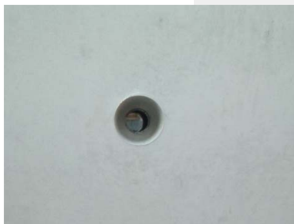
Fig. 8 - Dettaglio del faccia a vista
