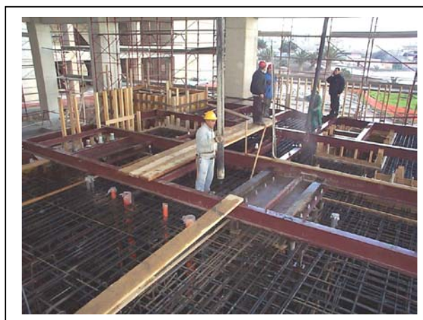
Fig. 2 Particolare della superficie del blocco-fondazione e della sua armatura, immediatamente prima del getto.
