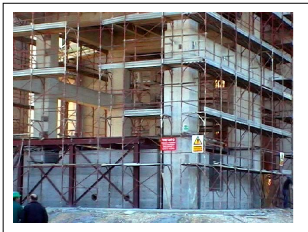
Fig. 6 Vista del basamento dopo la scasseratura a 7 giorni.
