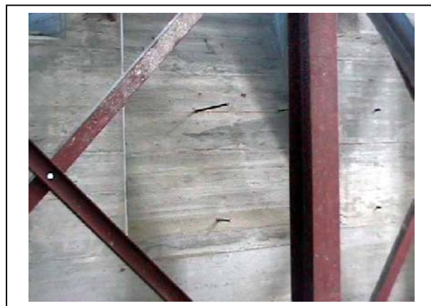
Fig 7 Particolare di un lato del basamento.
